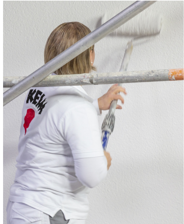
Recharger le rouleau et appliquer une seconde passe à la verticale
